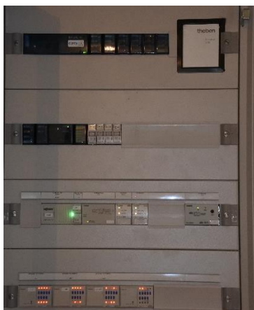
Le micro-serveur TheServa S110 est conçu sans ventilation pour un fonctionnement continu.
