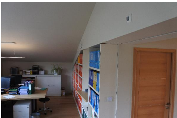
Le PresenceLight dispose d'une zone de détection à 180° pour un rayon de détection de 8 m.
